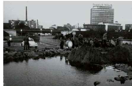
Sandsackwall Steindamm Ecke Hamburger Straße
