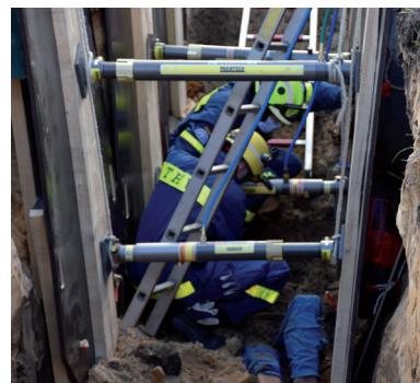
In der gesicherten Grube können die Einsatzkräfte gefahrlos die Person retten
