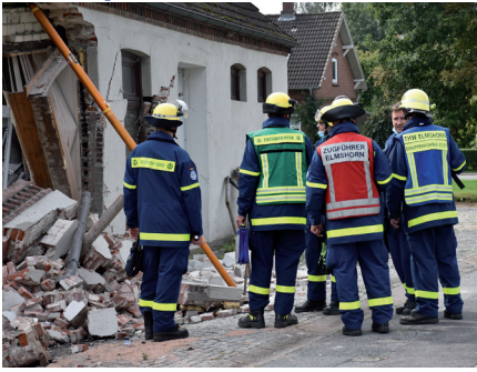
Gemeinsam mit dem THW Pinneberg wird das Gebäude gesichert
