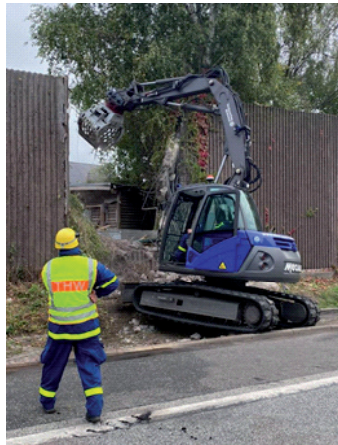
Der Bagger von THW Wandsbek im Einsatz
