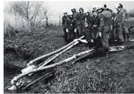
THW und Feuerwehr beim pumpen
