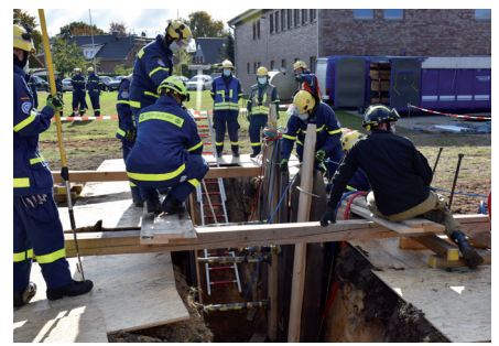
Mit Rettungstafeln und Stützen wir die Grube gesichert
