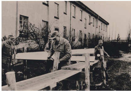
Rückbau der Behelfsstege im Lönsweg
