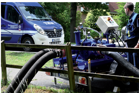
Der erste Einsatz für die umgebaute Flygt Schmutzwasserpumpe
